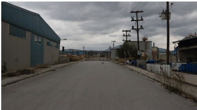
BIO.ME – hinter den Toren der stillgelegten Fliesenkleberfabrik
